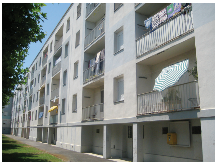
Groupe HLM Bigot (1959-1960, arch. : Jacques Van Migom et Jean Pélissier, 96 logements) : vue actuelle (cl. EMJ, 2008).
