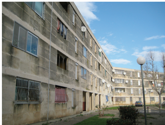
Groupe HLM Barriol (Arles, 1970-1972, arch. : Jean Delbès, 564 logements) : vue actuelle (cl. EMJ, 2008).
