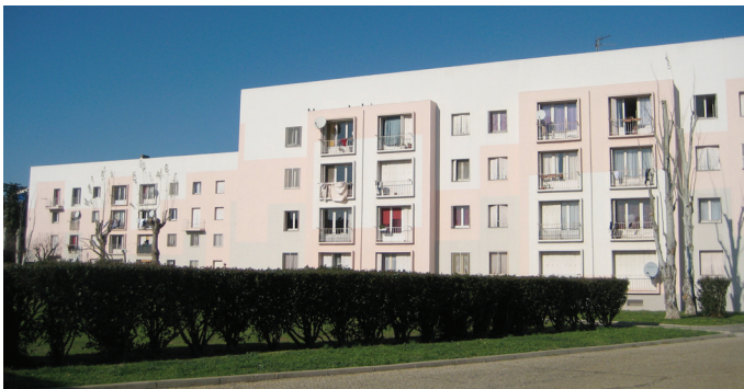
Groupe HLM Montmajour (1950-1953, arch. : Pierre Vago, 72 logements) : vue actuelle (cl. EMJ, 2008).
