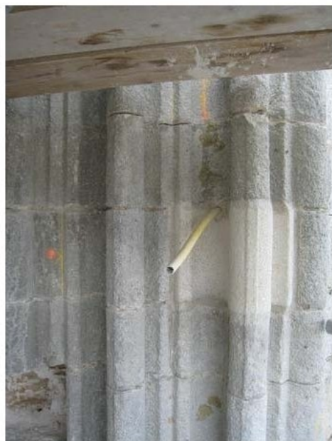
Injection de coulis (à base de chaux et de sable) pour consolider l'ensemble de la maçonnerie
