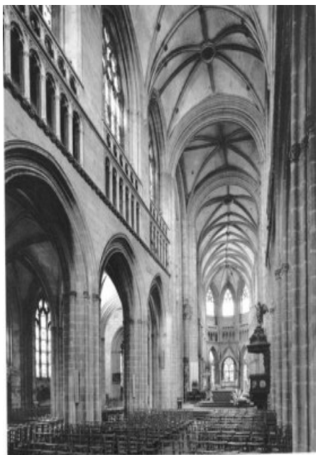
Nef avant restauration
