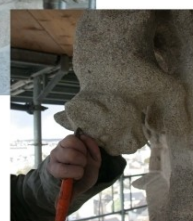
Travaux et restauration de sculpture sur la flèche
