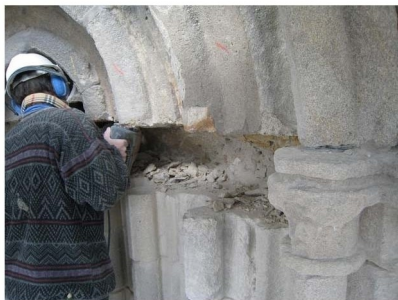
Les chapiteaux trop abîmés sont enlevés et retailés à l'identique
