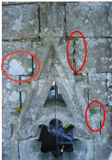
Dégradations sur une fenêtre de la flèche nord : joints ouverts, mousse et champignons, sculpture en mauvais état
