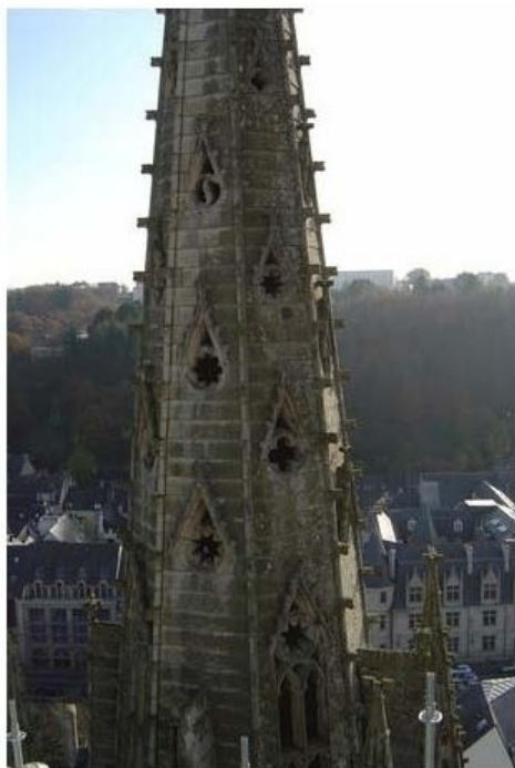
Dégradations sur la flèche sud
