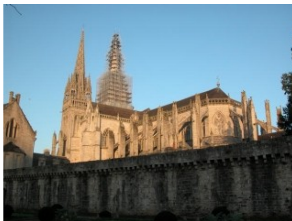
Cathédrale en restauration - 2005
