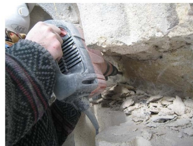
Le mur est piqueté pour enlever les restes de l'ancienne maçonnerie
