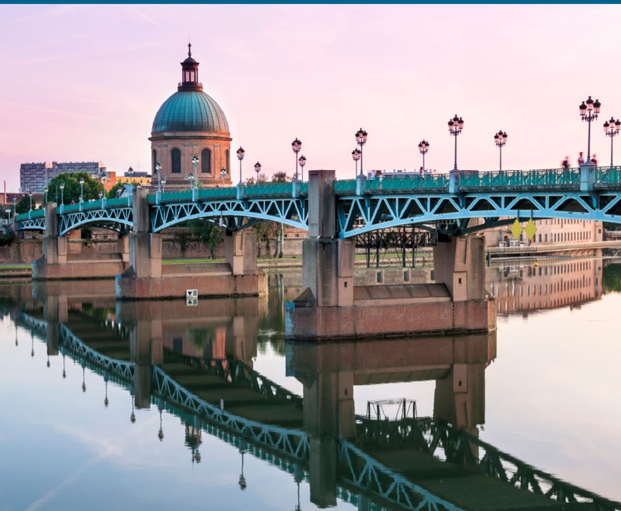
Dans la Ville d'art et d'histoire de Toulouse (Haute-Garonne), vue sur le Pont Saint-Pierre et ses poutres métalliques en treillis, 1987
