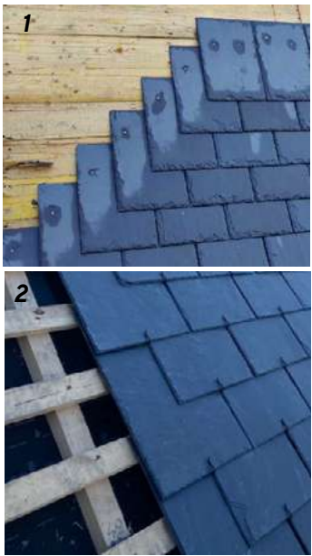
1. Ardoises posées au clou sur un voligeage jointif 2. Ardoises fixées au crochet sur liteaux en bois
