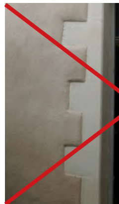
✗ Enduit en sur-épaisseur ou lacunaire par rapport à l'encadrement de baie
