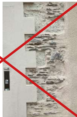
✗ Enduit en sur-épaisseur ou lacunaire par rapport à l'encadrement de baie
