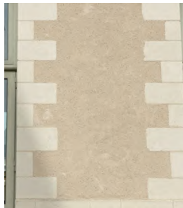
✓ Enduit affleurant à l'encadrement de baie
