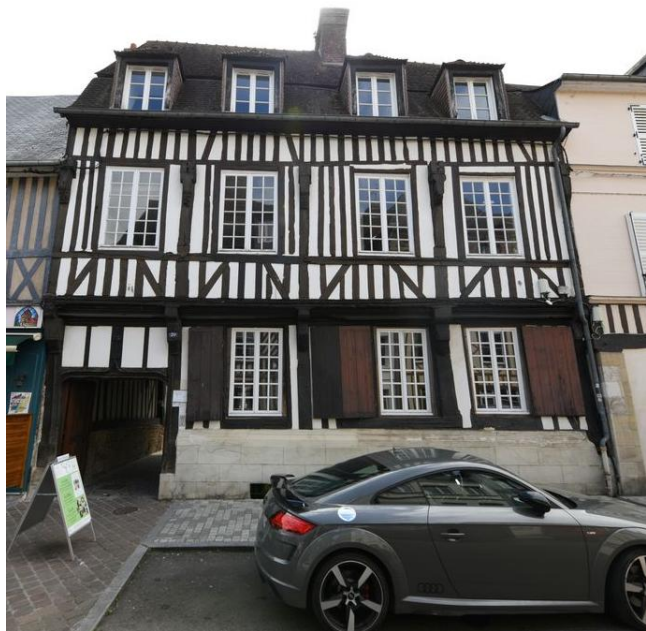
Maison à pans de bois, Pont-Audemer (27)
