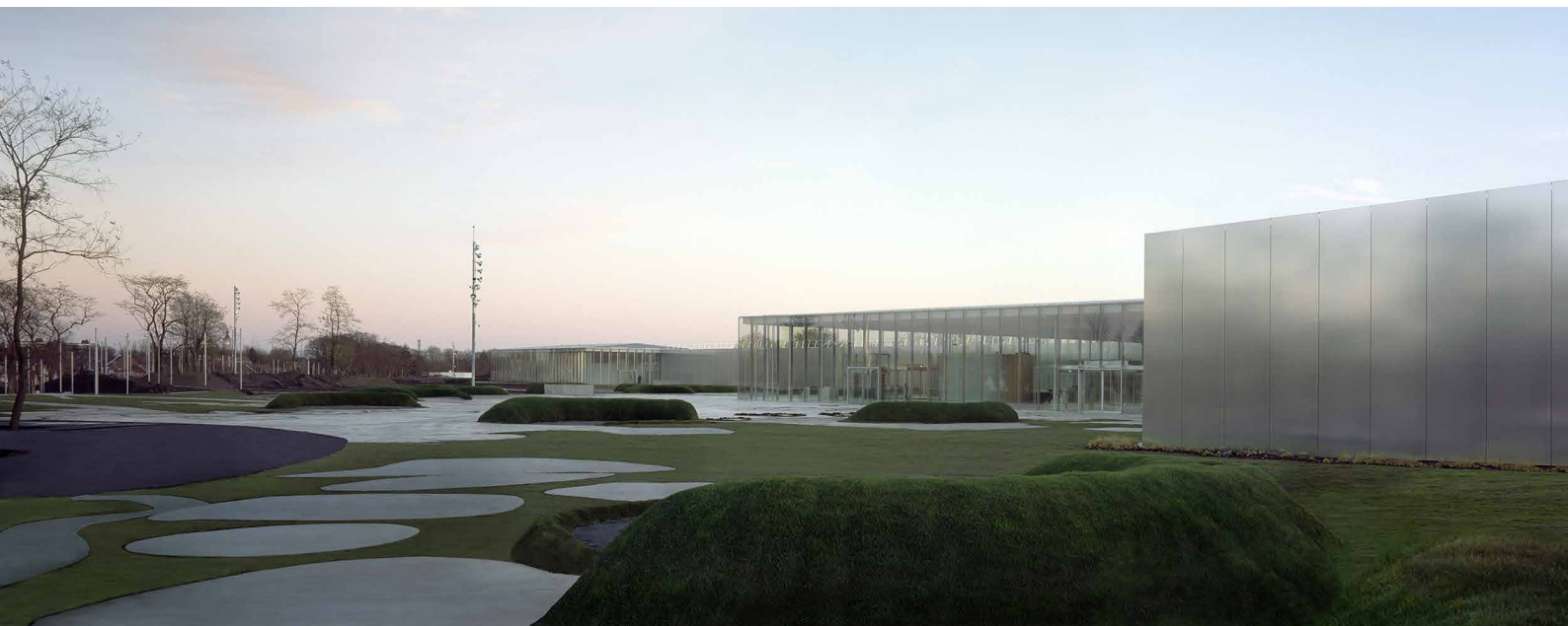
Les façades du Louvre-Lens, labellisé ACR, se confondent avec le ciel par temps nuageux. © Musée du Louvre
