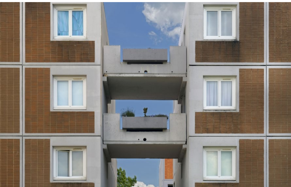
Modèle « Maille » à Arques (Pas-de-Calais), construit dans la fin des années 80, première pierre d'un tissu urbain réaménagé entre Saint-Omer et Arques.
