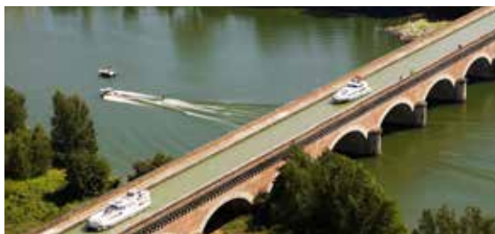
PONT-CANAL DU CACOR
