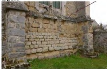
2016 • Vue de l'élévation Sud du transept. Altération profonde de la pierre en calcaire jaune du soubassement
