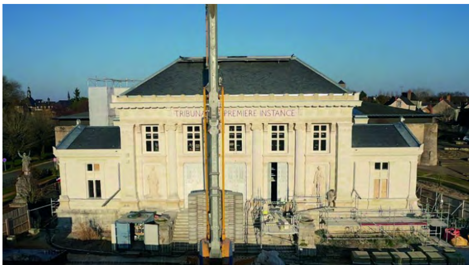
Photo Le kiosque.org, après travaux
