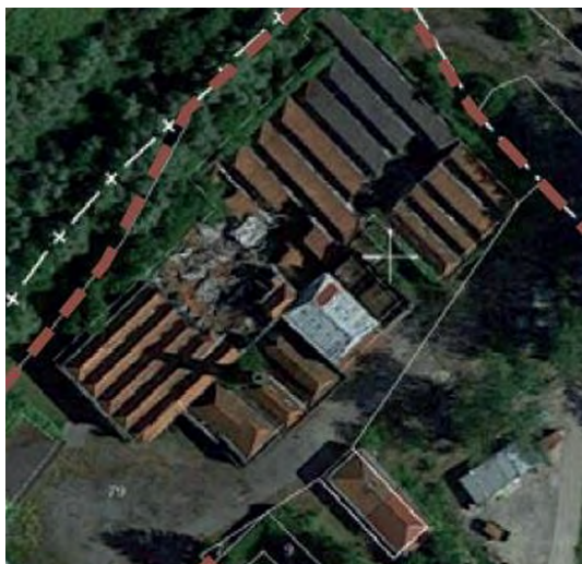
Extrait Esquisse projet Agence MAES – vue satellite (effondrement 2020)
