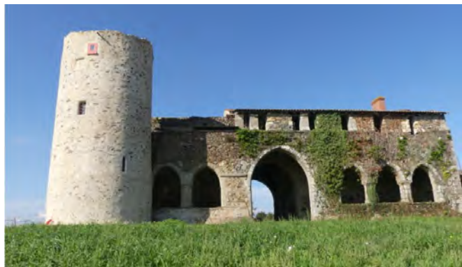
Photo Actu.fr avant restauration de la galerie, en cours de travaux (tranche 2)
