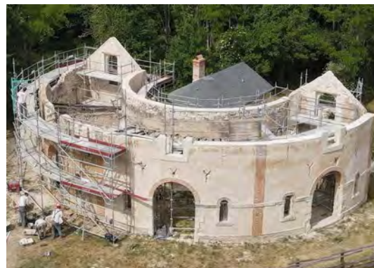
Photo Fondation du patrimoine en cours de restauration
