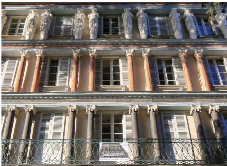
État avant travaux
