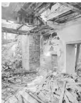
Cliché IVR53_19805600912X : Rez-de-chaussée, pièce principale, état actuel, vue prise du sud-ouest (1980)
