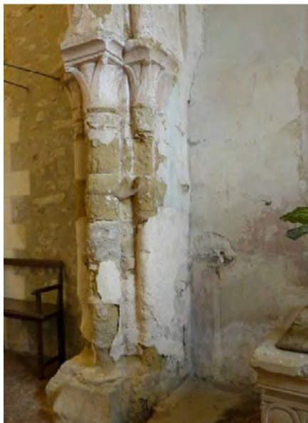
2016 • Vue de l'élévation Sud du transept. Altération profonde de la pierre en calcaire jaune du soubassement
