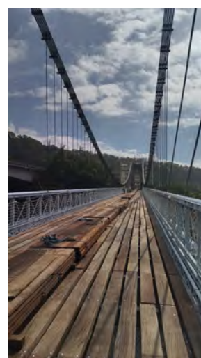
Fin des travaux (2023)
