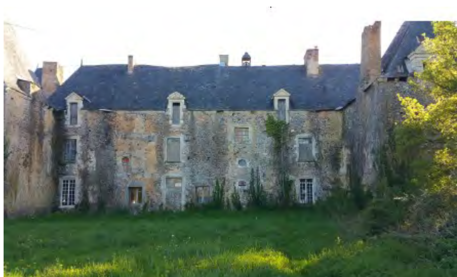
Photo Udap Mayenne avant travaux
