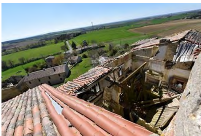
État des couvertures en 2019
