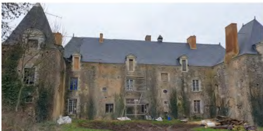
Photo Udap Mayenne après intervention sur les toitures et baies de la façade du logis
