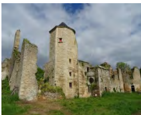
Cliché DRAC/UDAP DSC 3220 : vue prise du sud-est, mai 2023:
