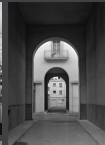
Passage entre bâtiments Source : © Fonds doc étude ML Fourchet SPI IVR24_103700049NUC_2
