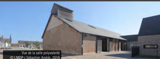
Vue de la façade occidentale du groupe scolaire © LMDP / Sébastien Andréi, 2019
