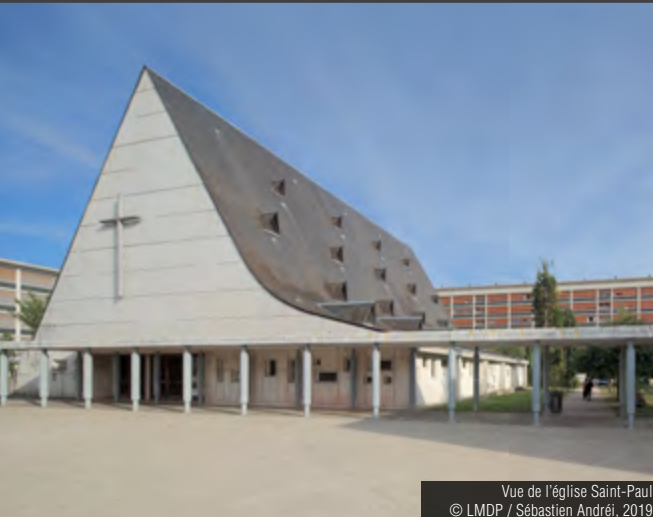
Vue d'ensemble du complexe paroissial © LMDP / Sébastien Andréi, 2019
