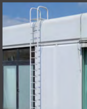
Détail de la façade occidentale et de l'escalier d'accès au toit © LMDP / Sébastien Andréi, 2019
