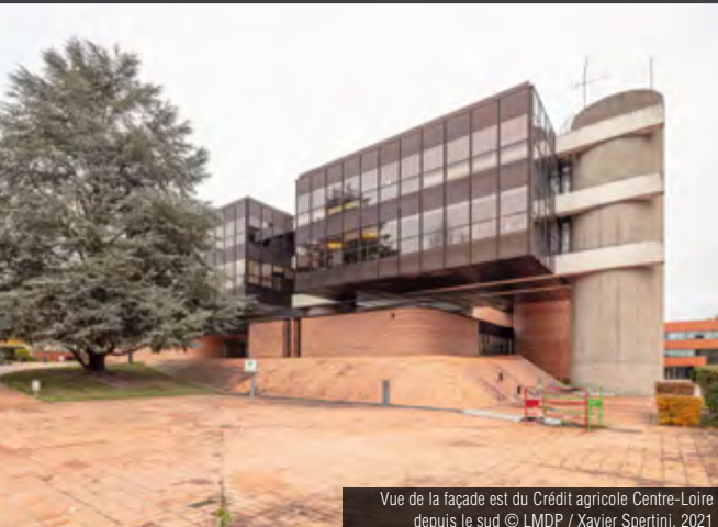
Vue de la façade est du Crédit agricole Centre-Loire © LMDP / Xavier Spertini, 2021
