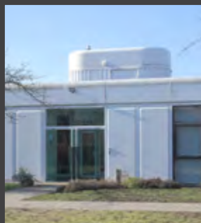
Vue de détail de la façade orientale © LMDP / Sébastien Andréi, 2019
