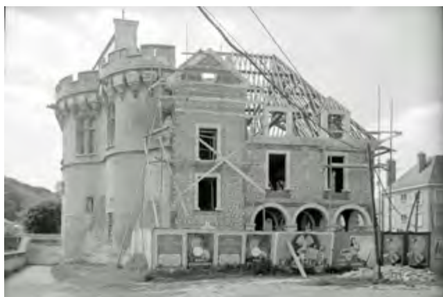
Vue du chantier de la Reconstruction Source : Images et sons en Vendômois
