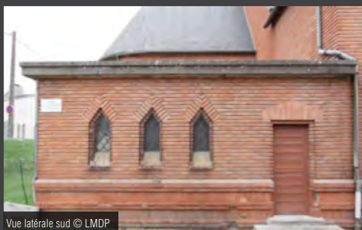
Vue latérale sud © LMDP
