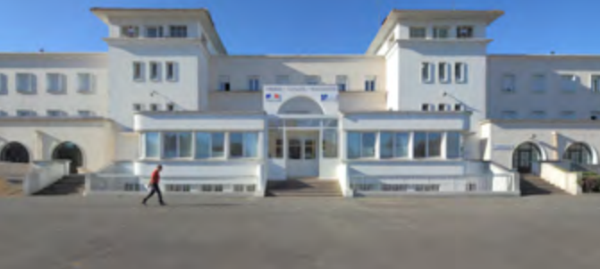
Détail de la façade nord du bâtiment principal de l'orphelinat © LMDP / Sébastien Andréi, 2019
