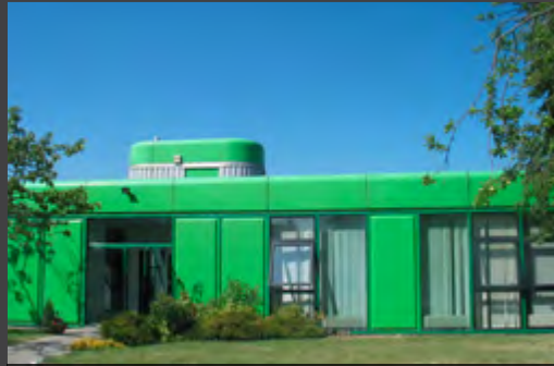
Vue de la façade occidentale de l'ancien siège des éditions Van de Velde, juin 2005. Source : Services techniques de la ville de Fondettes
