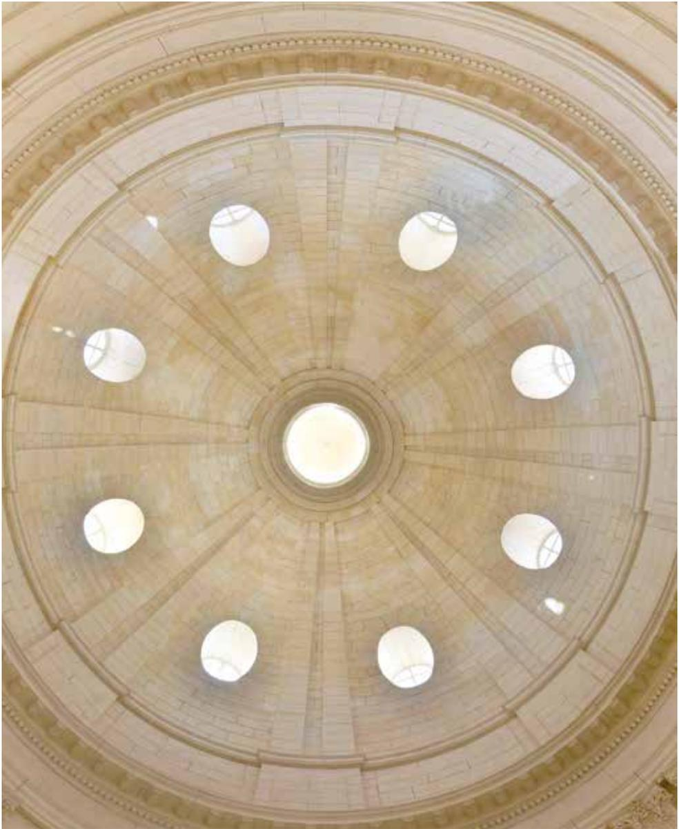
le calepinage après l'application d'un badigeon pour ne laisser apparaître que les lignes de l'édifice. Lors des restaurations passées, de faux joints creux ont été gravés, parfois jusque sur les vrais joints, dans la rotonde (sauf dans le lanternon), sur les murs du grand escalier et sur la voûte du portique, pour mettre en valeur le matériau de construction peut-être au détriment du
