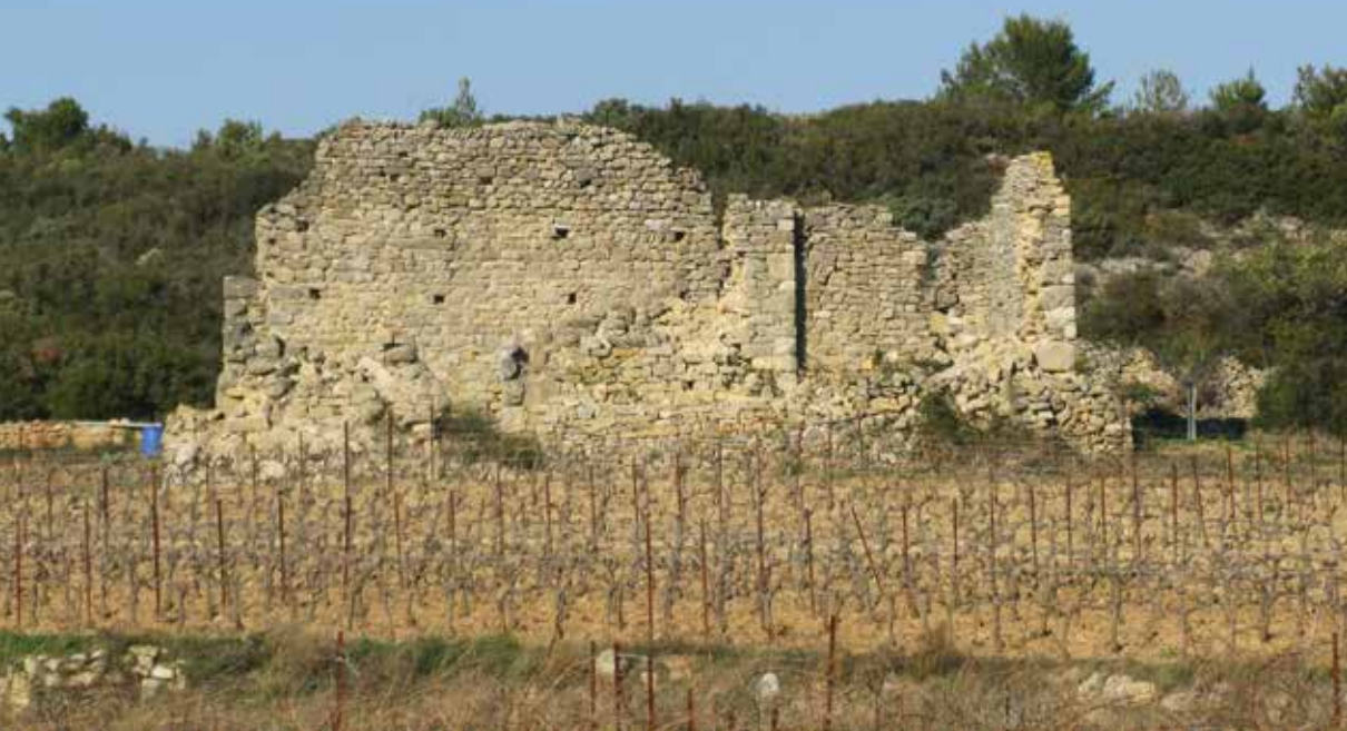
Fig. 64 - Église Saint-Jean-de-Cas vue depuis le sud.
