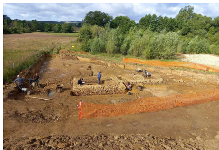
Vue générale du chantier. © CD08.
