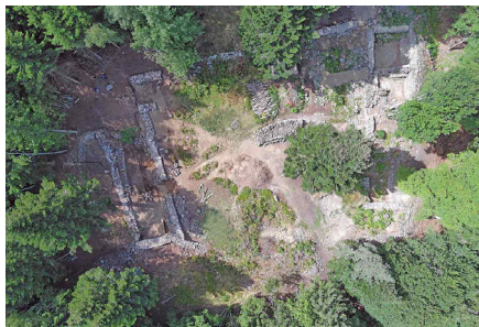
Vue zénithale du chantier. © Christophe Mathevot.
