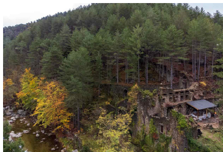
Vue générale du site. © Jean-Charles Méaudre.
