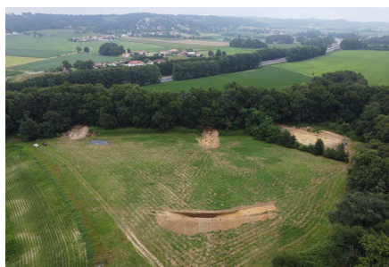
Vue aérienne du chantier. © Wilfried Labarthe.
