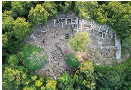
Vue aérienne du chantier. © C.-D. Rosa-Matton.
