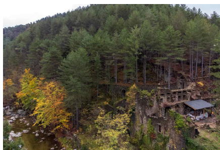
Vue générale du site. © Jean-Charles Méaudre.
