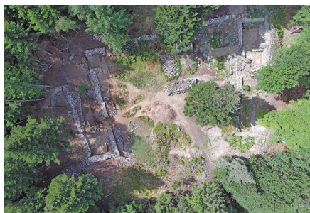
Vue zénithale du chantier. © Christophe Mathevot.
