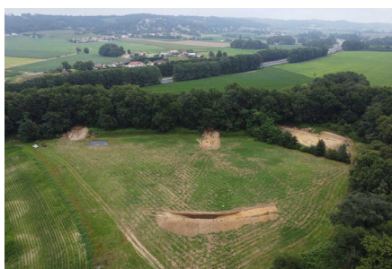
Vue aérienne du chantier. © Wilfried Labarthe.
