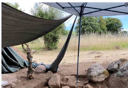
Parasols sur le chantier. © LRA.
