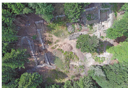
Vue zénithale du chantier. © Christophe Mathevot.
