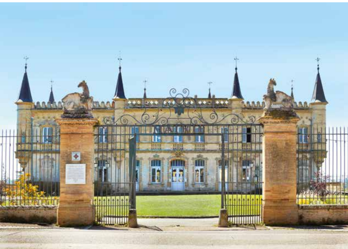
Portail d'entrée et façade principale.
