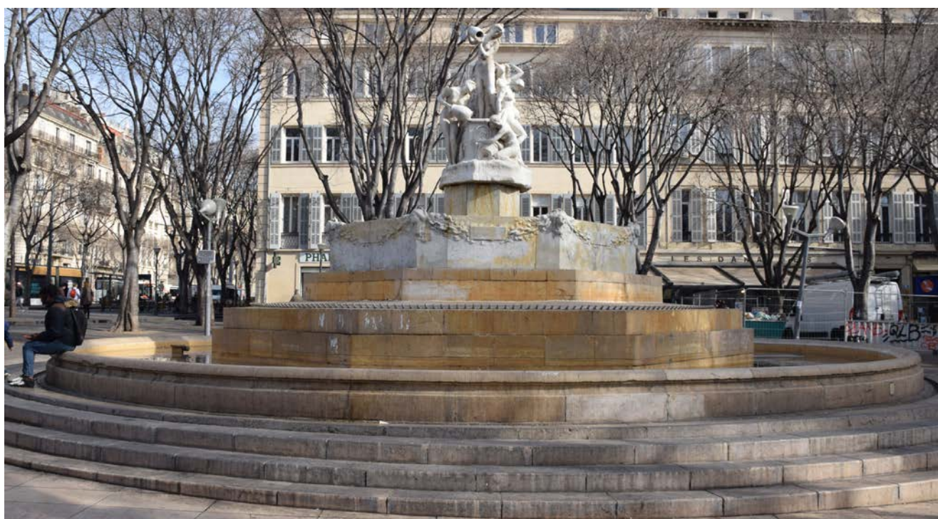
Fontaine des Danaïdes, Marseille (13) © DRAC PACA/CRMH
