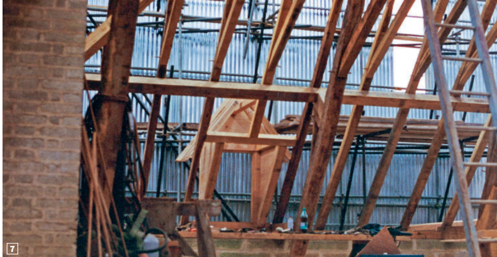
Restauration de la charpente des combles du donjon
