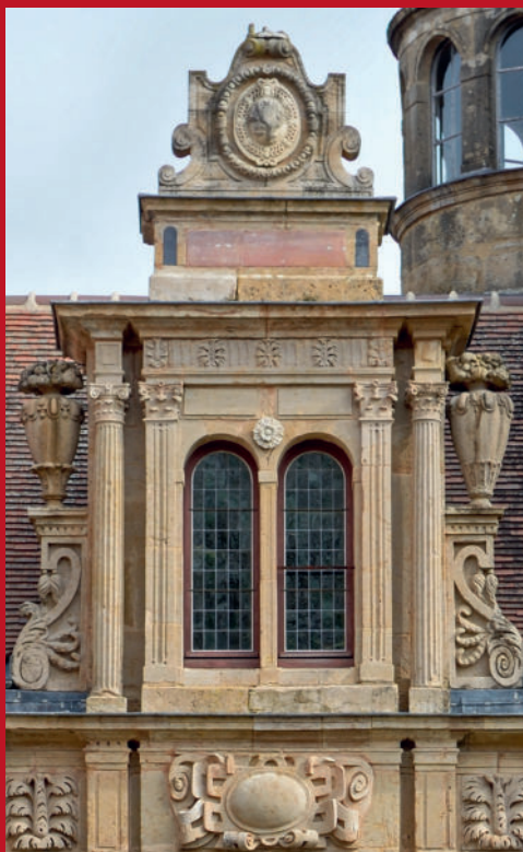
Lucarne de toiture au-dessus de l'avant-corps de l'aile nord
