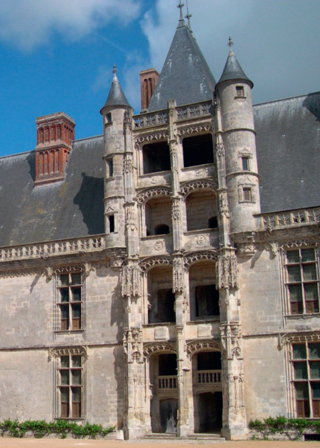
Exemple d'escalier à vis traité en loggia au château de Chateaudun © Patrick Giraud
