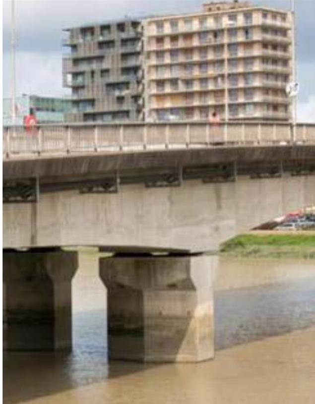
Passage de réseaux devant l'avant-bec des piles du pont Résal.
