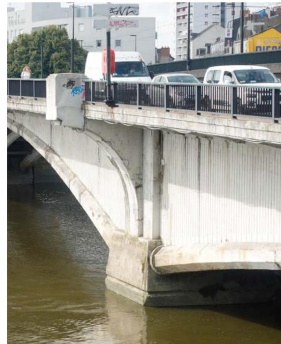
Garde-corps récents sur le pont Audibert remplaçant les garde-corps d'origine en fonte
