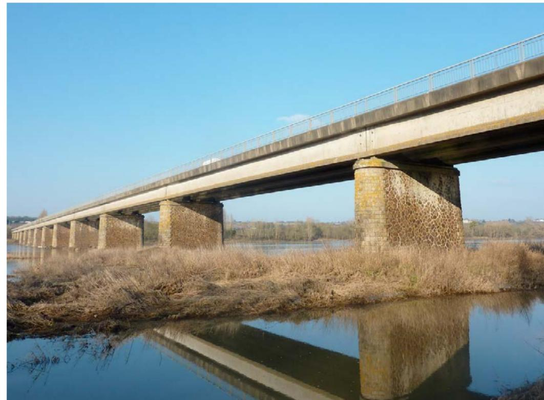
Le pont de Oudon-Champtoceaux, un tablier en béton de 1976 sur des piles maçonnées de 1890.
