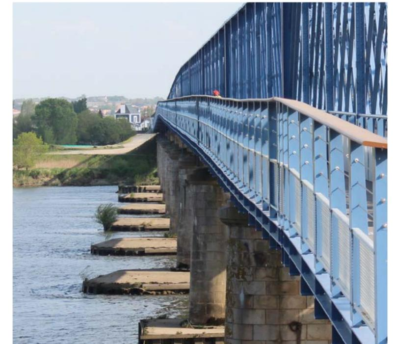
Passerelle en encorbellement rapportées sur le pont de Mauves-sur-Loire
