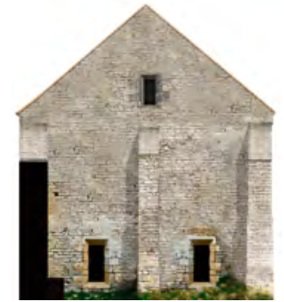
pignon sud après restauration
