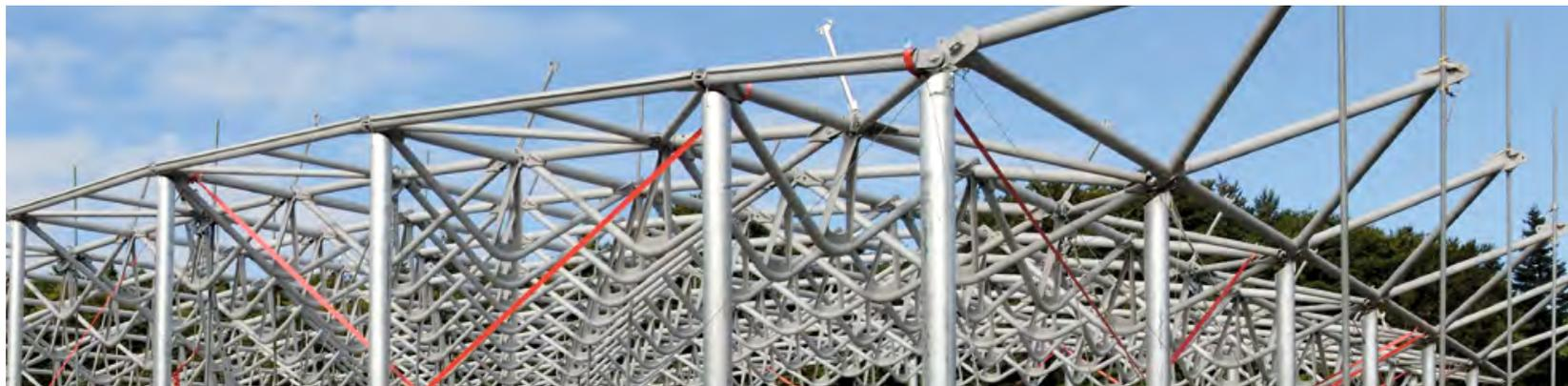
La structure est constituée de poutres en aluminium d'une longueur de 3,75 m et d'un poids de 43 kg, assemblées pour former un carré d'1,8 m de côté.
