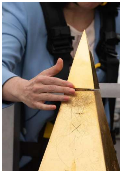
Installation de la pointe du pyramidion. ©Accorsini /ministère de la Culture/Sipa press
