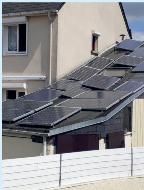
Exemple d'une mauvaise implantation de capteurs solaires sur une toiture © UDAP Maine-et-Loire
