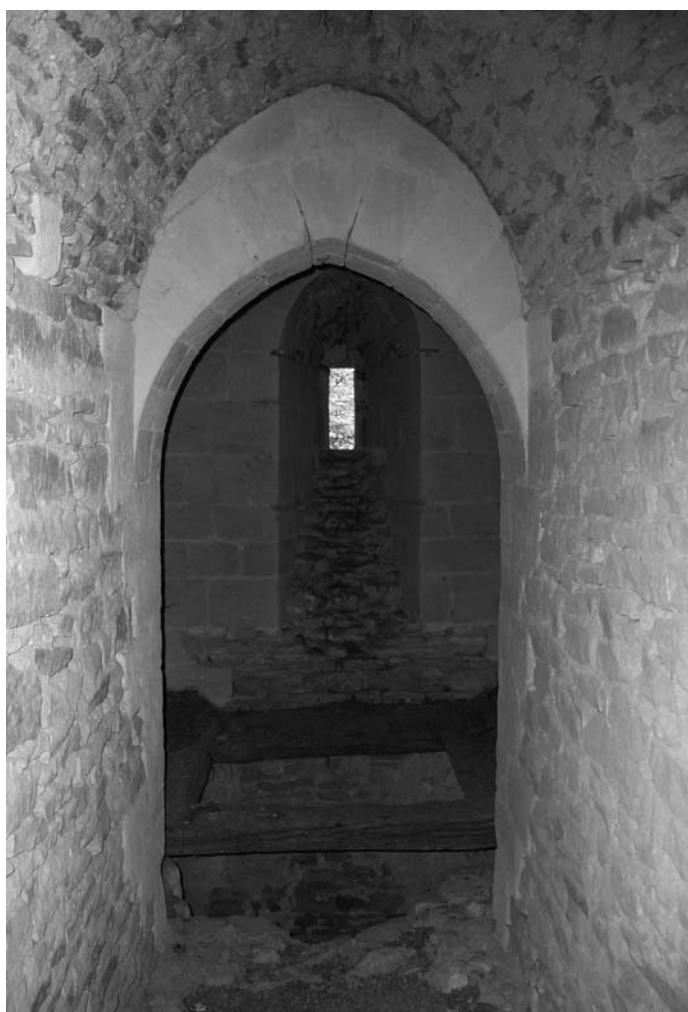
Fig. 44 – CHAMBOIS, donjon. Vue annexe nord-est.
