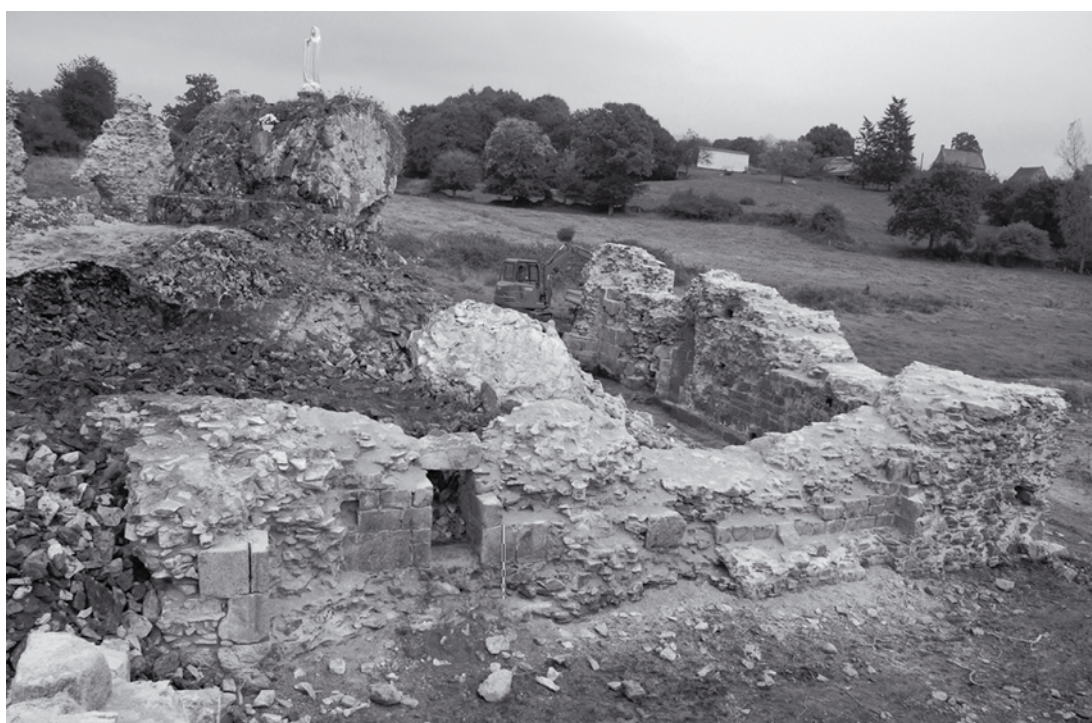
Fig. 42 – SAVIGNY-LE-VIEUX, abbaye. Vue générale du transept sud.
