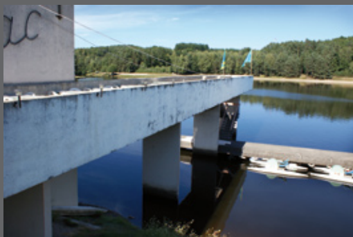
Passerelle sur pilotis
