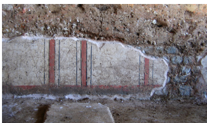
ill. 10: Merbes-le-Château (Belgique), villa. Exemple de consolidation d'un décor in situ dans la cave, 2006, Cliché R. Nunes Pedroso.
