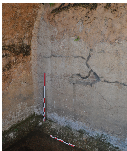
iii. 1: Aléria (Haute-Corse), enduit d'étanchéité, joint d'étanchéité et revêtement de fond de la citerne orientale de la Domus au balneum , 2011, cliché A. Coutelas.
