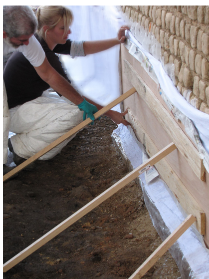
ill. 7: Vieux-la-Romaine (Calvados), forum. Dépose par un restaurateur d'une peinture murale conservée in situ : encollage par la face et pose d'une planche de réception, 2010. Cliché S. Groetembriel.
