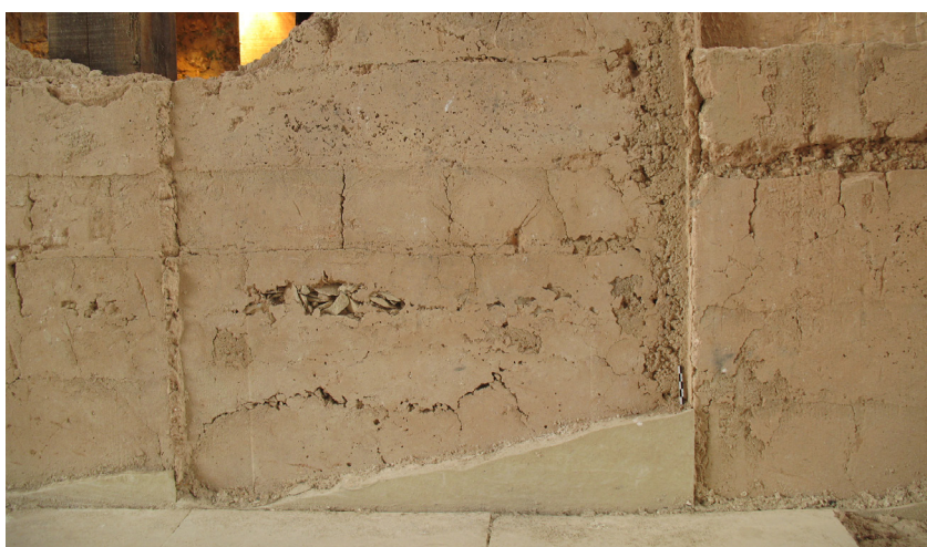
iii. 2: Chassenon (Charente), piscine à immersion des thermes de Longeas. Volumes de mortier de tuileau coulés derrière une plaque de calcaire fin (très largement récupérée), 2007. Cliché A. Coutelas.
