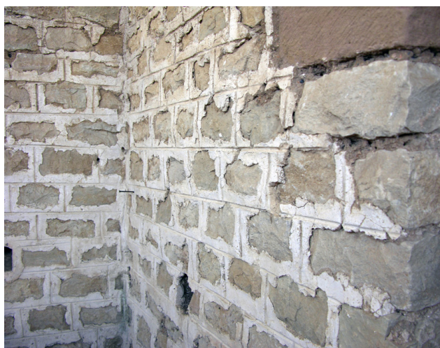
III. 3: Bliesbruck (Moselle), joints regarnis sur les murs de la cave du bâtiment II du quartier artisanal oriental. Cliché A. Barbet.
