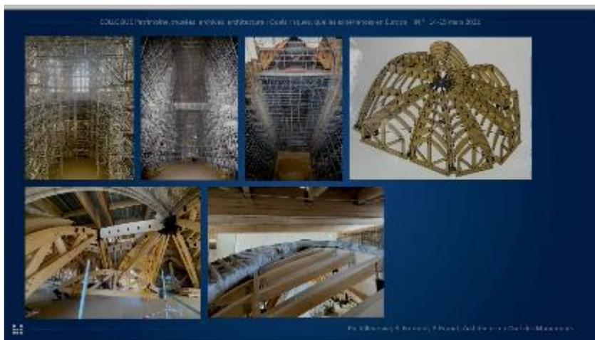
Pour finir sur les travaux de sécurisation, nous avons mis en place un parapluie, au-dessus de la toile provisoire posée au-dessus des planchers, ce qui permet d'ouvrir la croisée du transept et de faire l'approvisionnement, par exemple pour sortir les vestiges du jubé médiéval que nous venons de découvrir.
