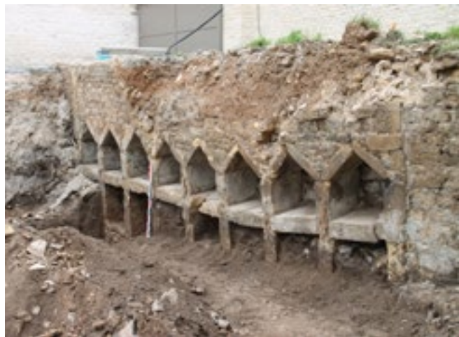
Caen, 58 rue Bicoquet : vue de rapprochée des niches aménagées dans le mur matérialisant l'ancien front de carrière (C. Billard).
