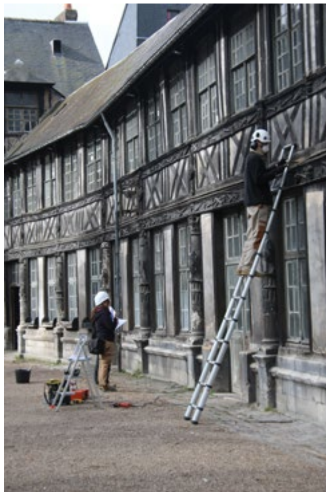
Rouen, aître Saint-Maclou : étude bâti et dendrochronologie en cours (A. Marais, Dendrotech).
