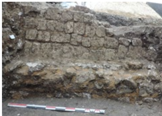
Le Vaudreuil, Le Golf, fig. 2 : vue vers l'est du mur médiéval et de sa fondation (N. Roudié).
