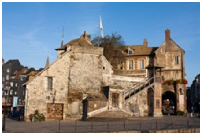
Honfleur, La Lieutenance : le bâtiment de la Lieutenance (F. Delahaye).
