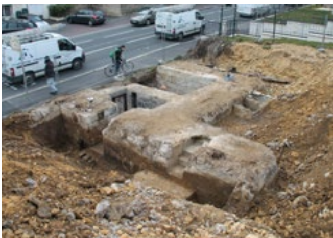
Caen, 116 rue de la Délivrande : vue de l'ouvrage à l'issue de la fouille (C. Billard).
