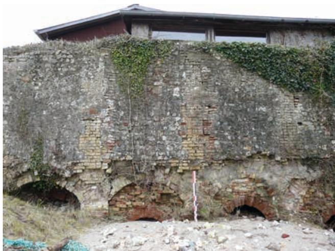
Cricquebœuf, l'estran, fig. 2 : vue partielle des couloirs de chauffe et leur réduction, sur la face ouest du double four à briques de 1841, (P. Moitrel).
