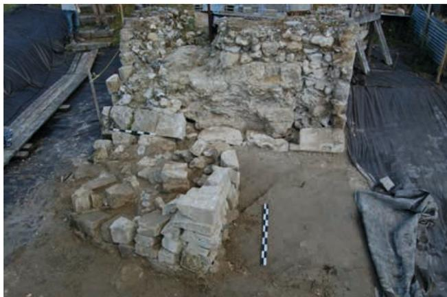
Harfleur, Porte aux Cerfs : coupe transversale du pont avec au centre le blocage de l'ouvrage du XIV<sup>e</sup> siècle et de part et d'autre les parements latéraux et le blocage sommaire entre-deux. Au premier plan, pile de pont sommaire (B. Duvernois).
