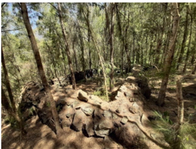
[Fig. 7] : Vestiges bâtis encore en élévation à Roche Plate (photo J. Vidal / SRA de La Réunion)
