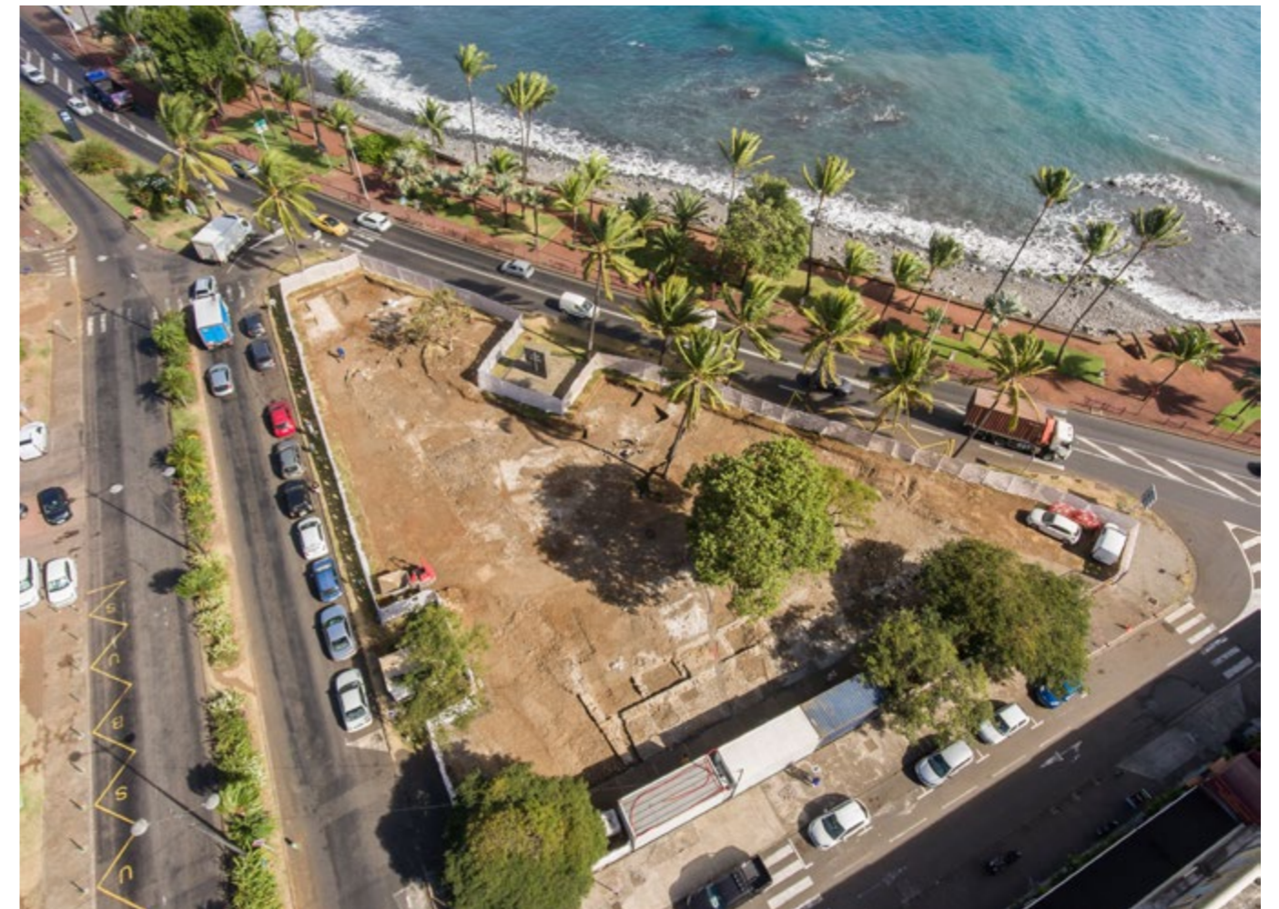
[Fig. 9]: Vue aérienne du chantier en cours de fouille (photo A. Vaccaro / Agence Wopé!)
