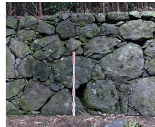
[Fig. 6]: Détail de l'appareil du mur 1204 en pierres sèches (photo T. Cornec / Inrap)
