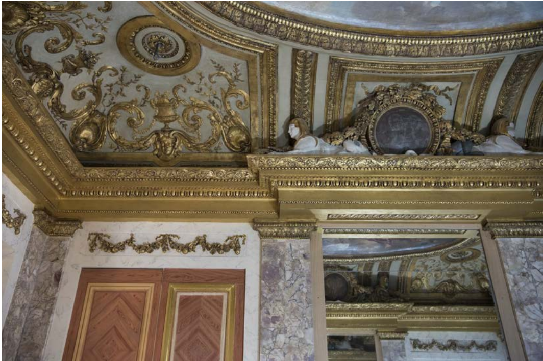
Salle à manger en cours de restauration (détail). © Archives nationales / Nicolas Dion
