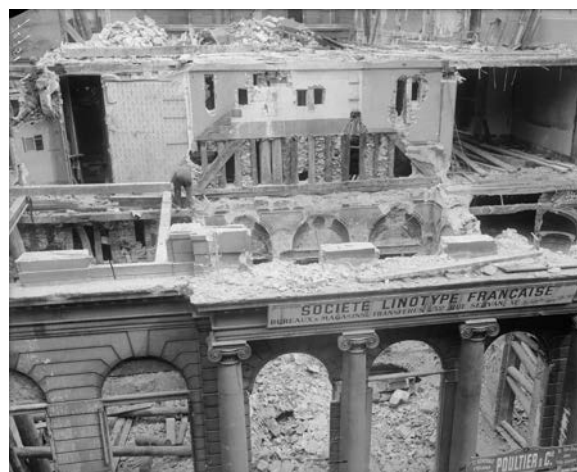
Emmanuel-Louis Mas, L'Hôtel de la Chancellerie d'Orléans en cours de démolition, négatif sur verre, 1924. Cl. Médiathèque de l'architecture et du patrimoine, dit. RMN-GP.
