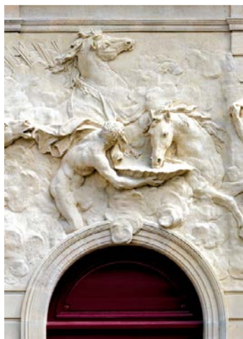
Cour des chevaux du soleil (cour des écuries) après travaux
