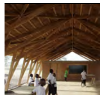
Toulouse Visite - Habitation bioclimatique et éco-construction
