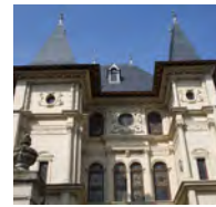
Orléans Visites Flash: Façades restaurées de l'Hôtel Cabu
