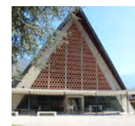
Ugine Visite du centre d'art de Curiox-Ugine
