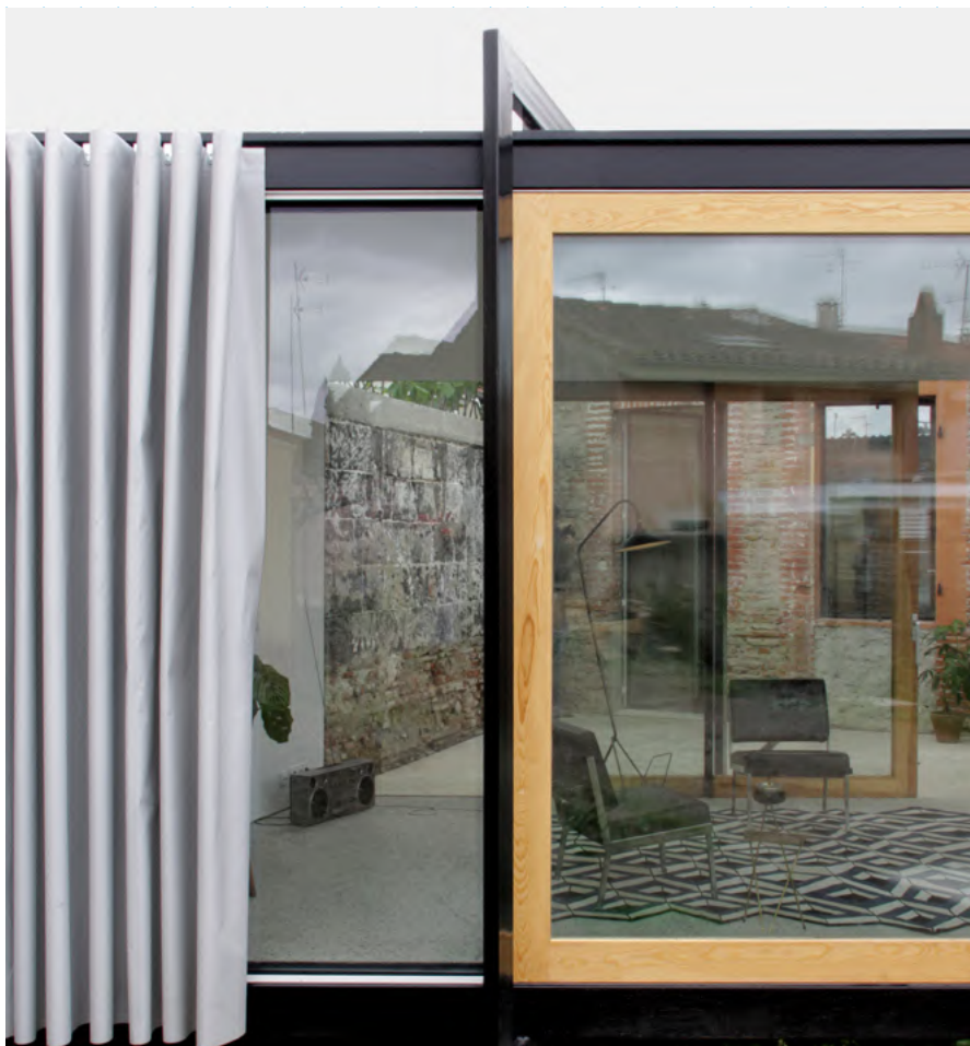
BAST Bureau Architecture Sans Titre - Lauréat Prix Architecture Occitanie 2017 - Rehabilitation et extension d'une maison, Toulouse (31) © BAST
