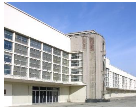
Le Bourget - Aérogare Henri DECAUX architecte
