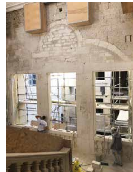
Restauration d'anciennes baies bouchées dans l'escalier d'honneur après purge des enduits.
