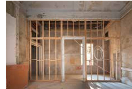
Décor intérieur du 18 e siècle avec menuiseries restaurées.
