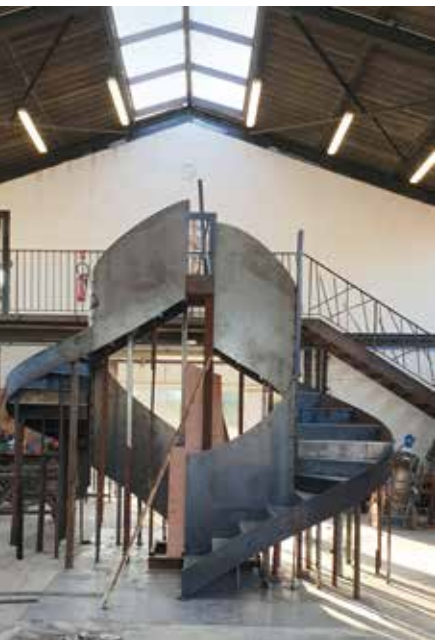
Montage à blanc des escaliers métalliques dans les ateliers de l'entreprise Molinelli Métallerie d'art, avant leur remontage sur site.
