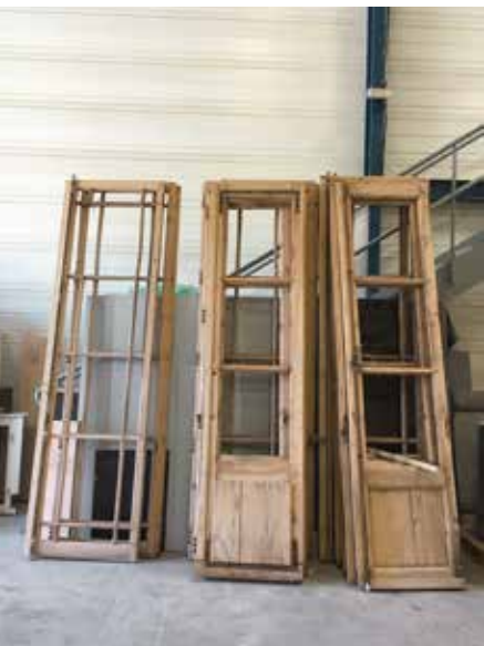
Vantaux déposés dans les ateliers de l'entreprise Les métiers du bois après décapage. Chaque élément a été inventorié en prévision de sa repose.
