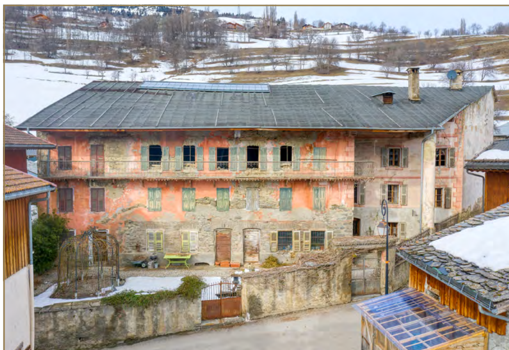
Ferme de Villarivon © Fondation du patrimoine_MyPhotoAgency-H. Rolland
