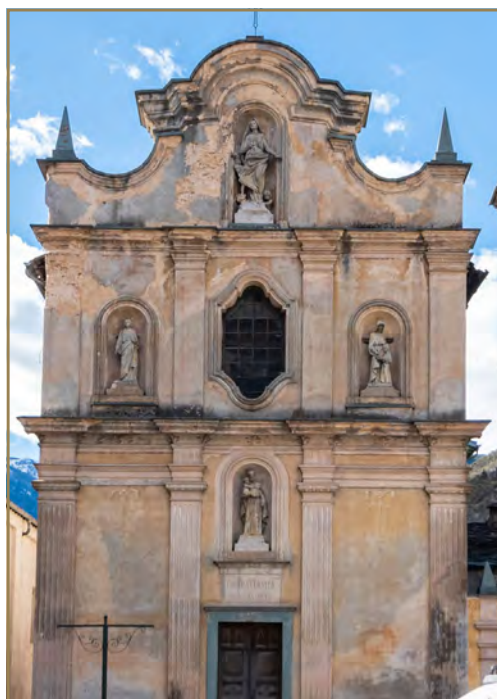
Chapelle de l'Assomption © Fondation du patrimoine_MyPhotoAgency-Y. Raout
