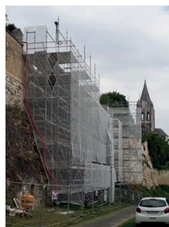
Loches. Restauration des remparts. © DRAC CVL/UDAP 37
