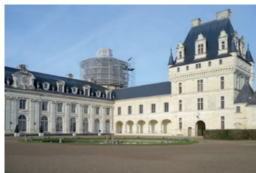
Château, vue de la Tour nord-ouest en restauration © F. Lauginie
