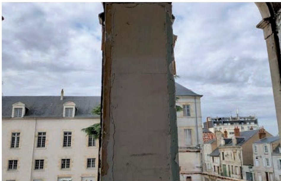
16. Orléans (45). Chantier site de La Madeleine. Cl. Xavier Creff
