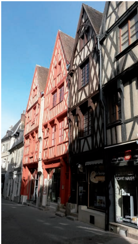
Bourges (18). 85-87 rue Mirebeau : restauration des façades sur rue, inscrites au titre des MH Cl. UDAP 18
