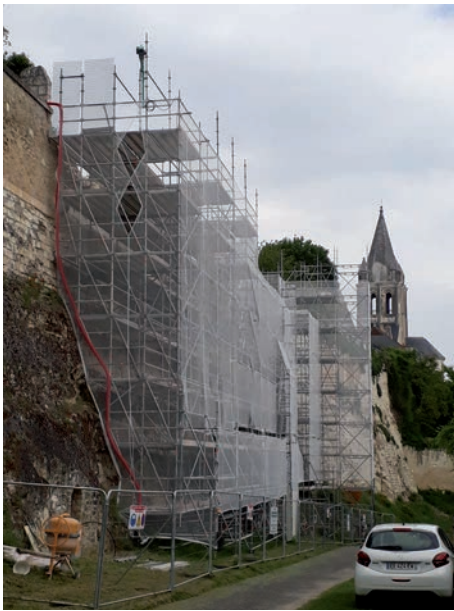
13. Loches (37) Restauration des remparts. CL UDAP 37
