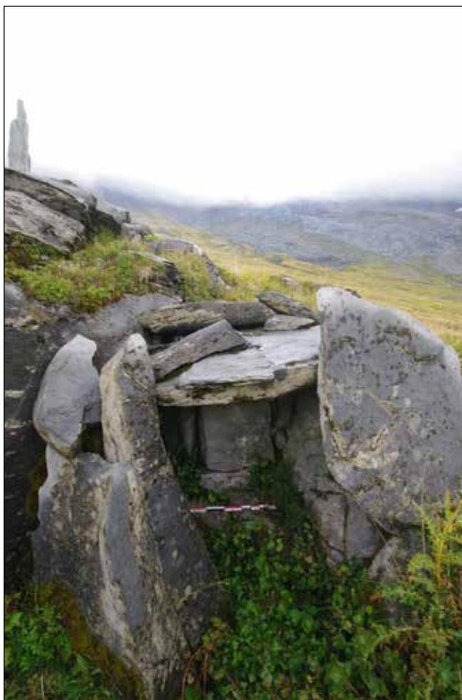
Figure 2 : Cramo : abri de berger en pierres sèches (site 070) situé sur le plateau des Salamanes (vers 200 m d'altitude). Cliché J. Laidebeur – Dép. 74.
