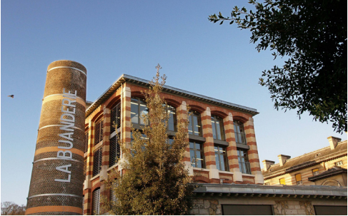
Médiathèque Buanderie-Anne Capezzuoli © Mairie de Clamart
