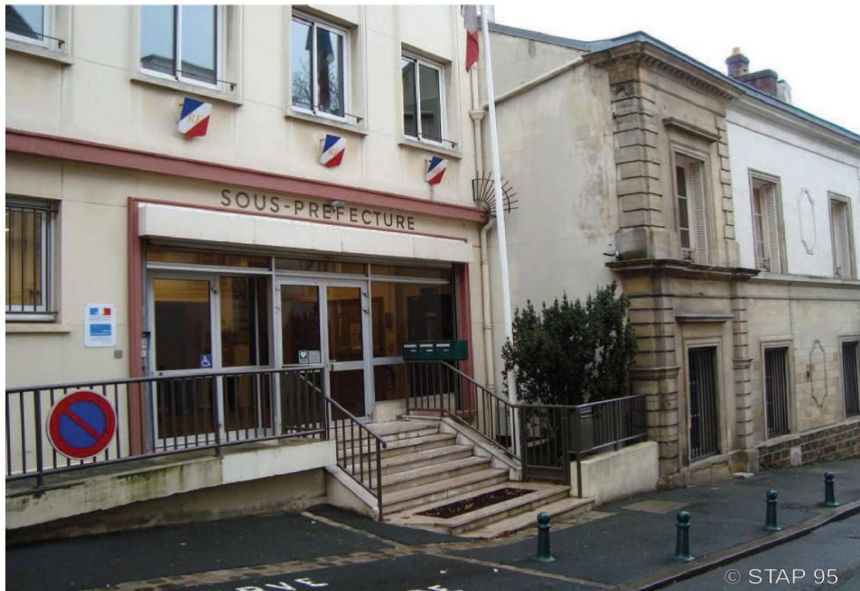
cliché du bâtiment – STAP 95 au 3ème étage
