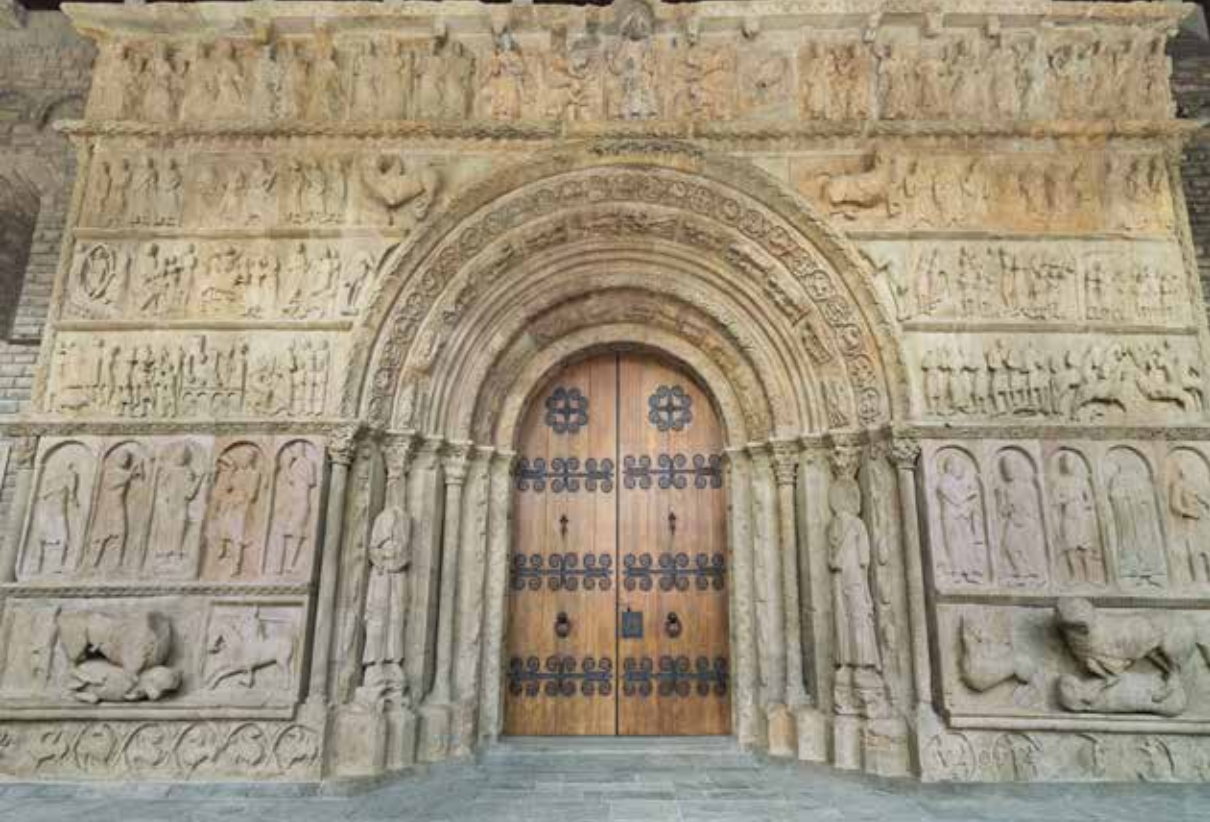
(fig. 7) Vue générale après intervention.
