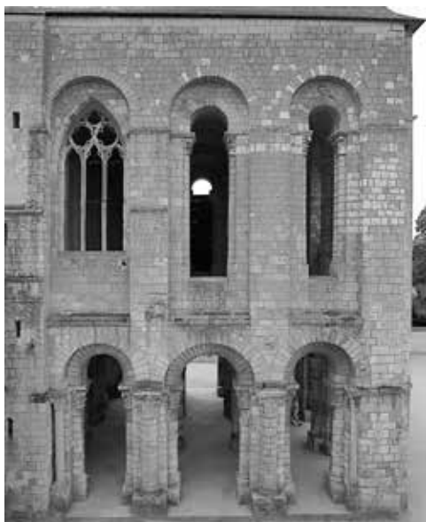
(fig.1) Façade nord de la tour-porche avant travaux.
