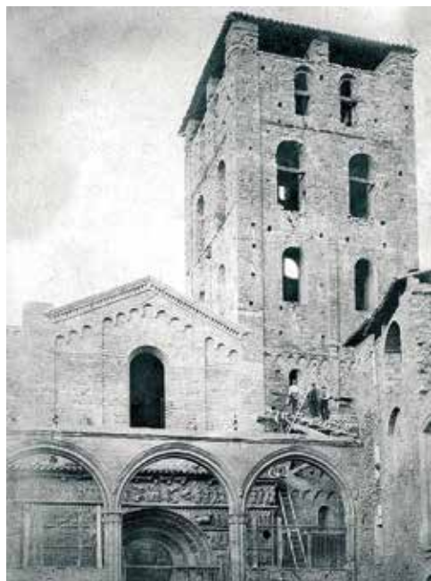
(fig. 3) La reconstruction du toit de l'atrium entre 1888 et 1893.
