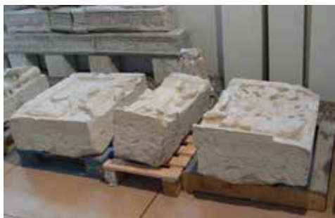
(fig. 2) Plaque sculptée constituée de trois blocs après dépose.
