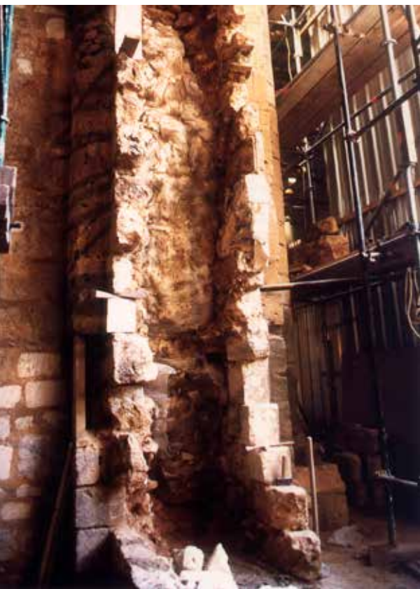
(fig. 2) Suppression du blocage interne des murs.
