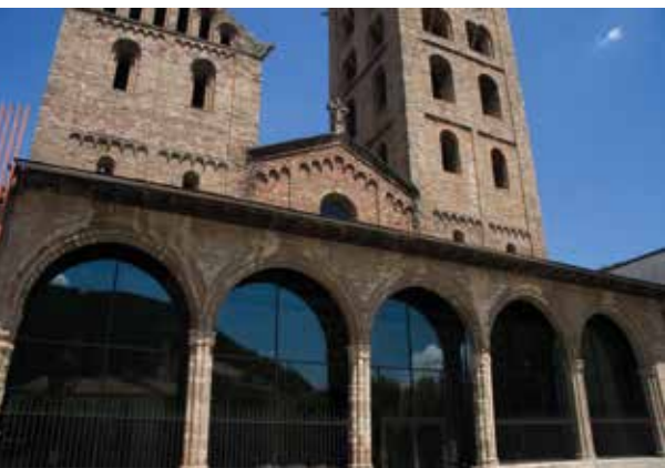
[fig. 4] Nouvelle fermeture de l'atrium par des baies vitrées pour isoler le portail (SPA 1994).
