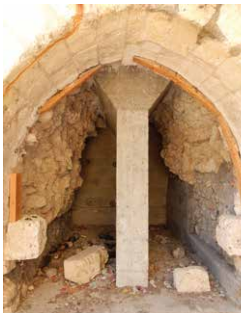
(fig. 10) Vue de la cavité creusée dans le piédroit de droite avec son pilier de béton, 2018.
