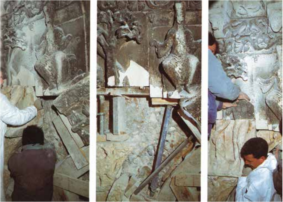
(fig. 4) Dépose-repose d'éléments sculptés de la frise.
