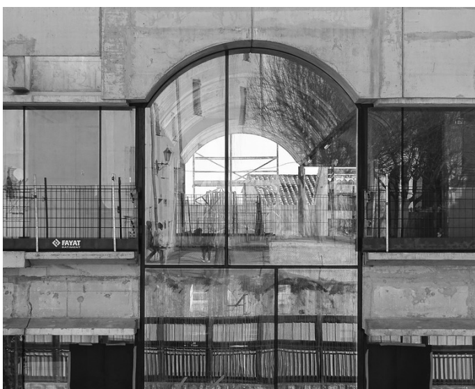
Chantier de la médiathèque de Grasse © Moïse Sadoun
