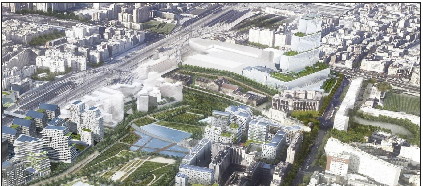
Reconversion des Ateliers Berthier
