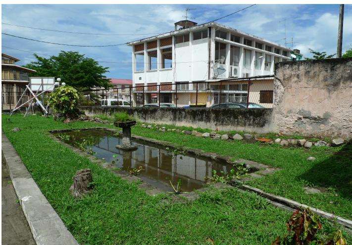
La maison, orientée Nord-Sud, est construite en moellon enduit pour le rez-de-chaussée et l'étage, tandis que la façade sur jardin est en bardage bois. Les fenêtres incluses dans les maçonneries reçoivent des encadrements en pierres de taille.
