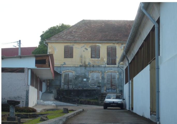
Plusieurs désordres touchent les parements : enduit de ciment gris, pierres de taille très dégradées, présence de sels et d'humidité dans les maçonneries, etc. Les bardages en bois ainsi que la structure sont touchés par des infiltrations, quelques bois sont pourris, et des attaques de parasites xylophages sont à noter.
