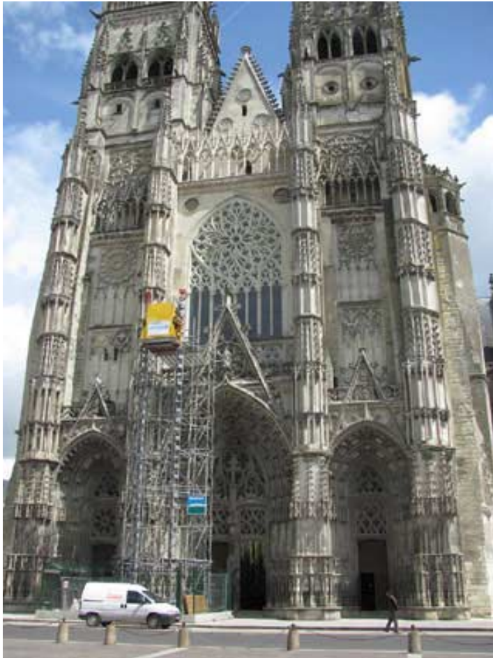
La façade occidentale après la restauration de la rose.
