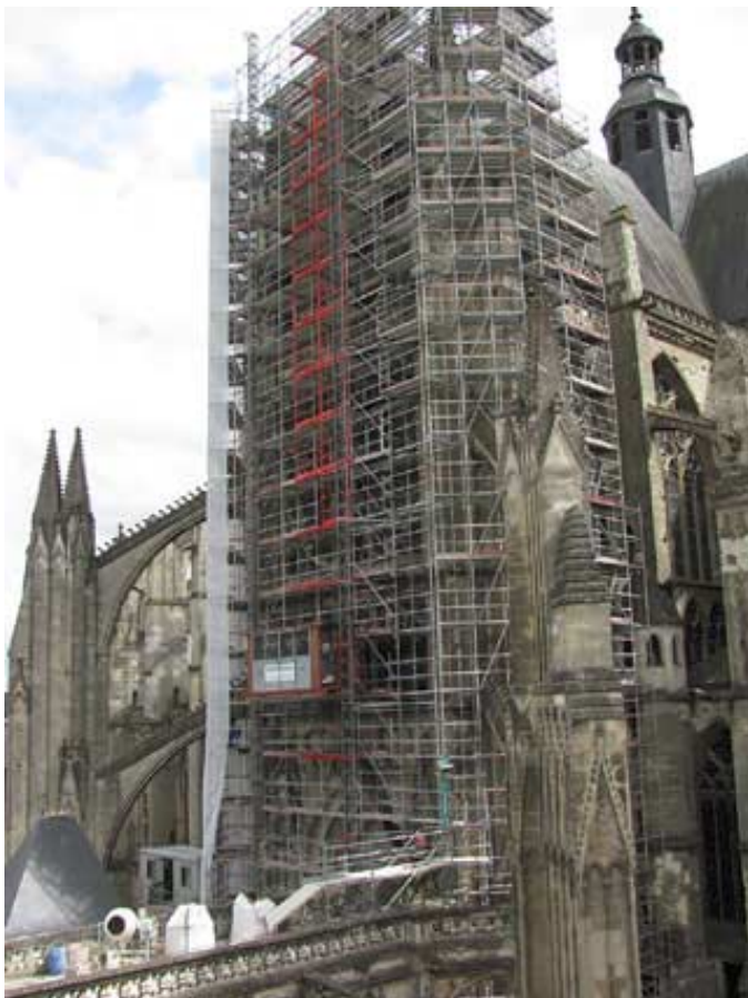
Le chantier du transept nord
