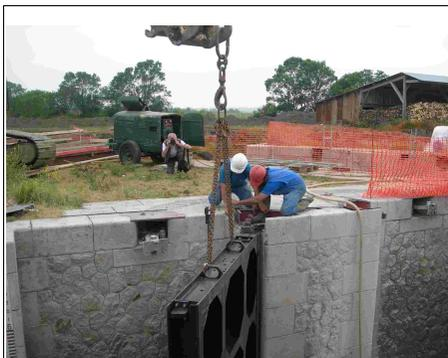
Illustration 45: la pose de la porte le 11.06.07. On voit bien la réutilisation des mécanismes des plus d'un siècle, nettoyés et rénovés.
